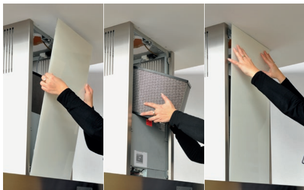
Легкая замена фильтра благодаря съемной панели короба.
